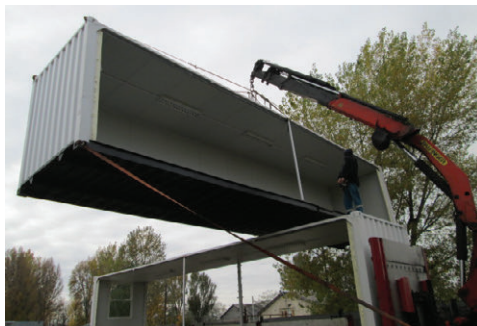
40' konténergység telepítése darusautóval
