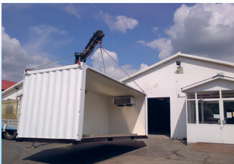
ColdBox Mega telepítés közben
