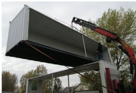
40' konténer egység telepítése darusautóval
