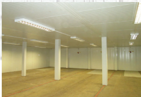
Kisebb méretű csarnok szigeteléssel, világítással
