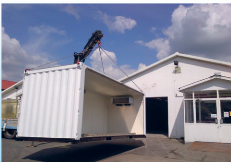
ColdBox Mega telepítés közben
